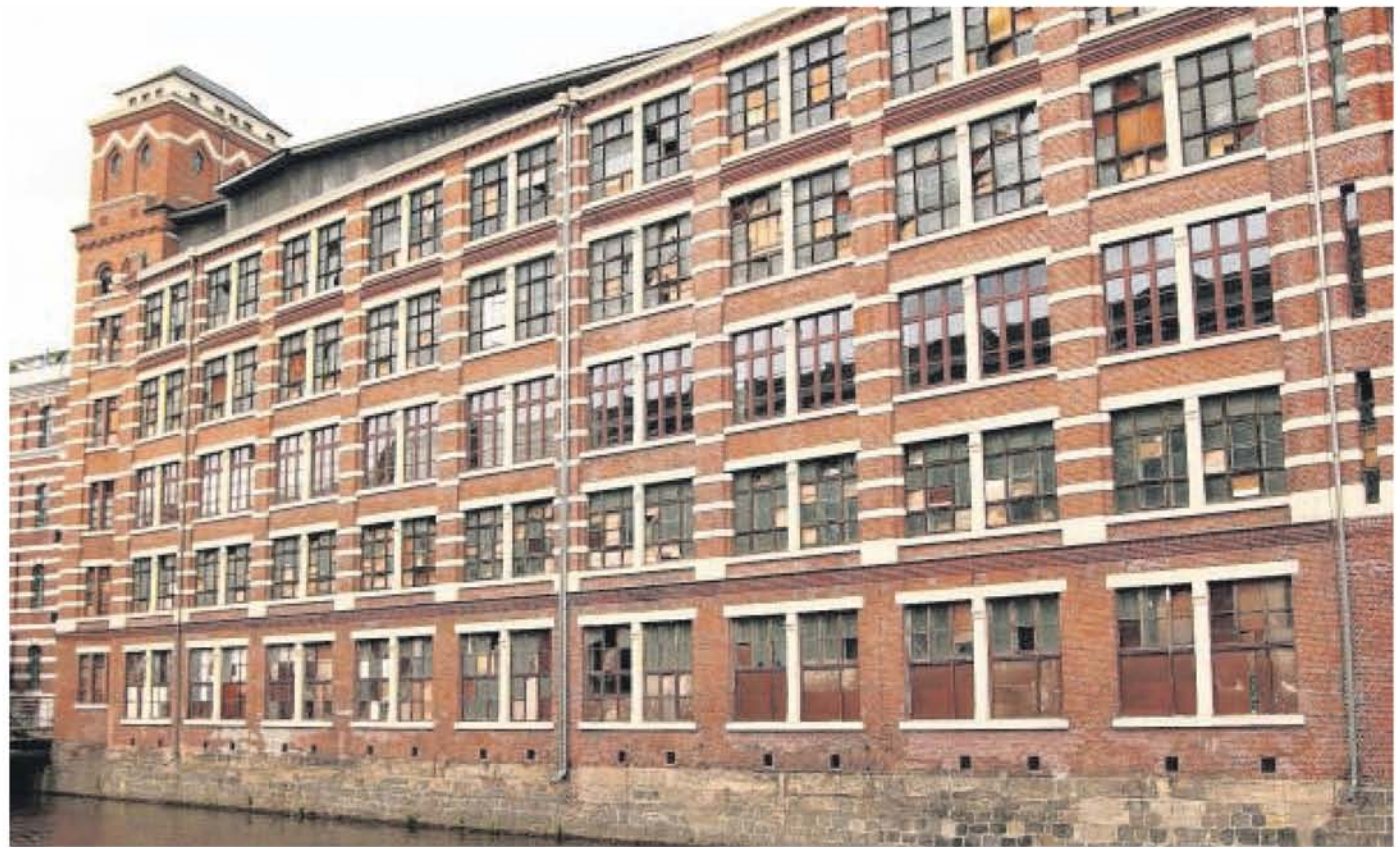
Die Fenster zeigen es deutlich: Am Hochbau Mitte der Buntgarnwerke ist erst eine Etage (genau in der Mitte) saniert. Fotos: Ines Christ
