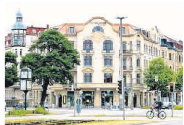
Sanierung abgeschlossen: Das Jugendstil-Gebäude am Ostplatz 2 wurde für 2,6 Millionen Euro herausgeputzt.
