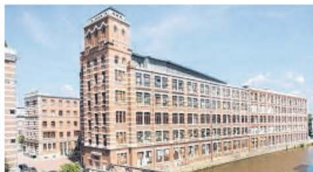
In den Turm an der Westseite kommen gleich zwei Lifte.
