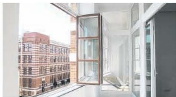
Blick in die Loggia mit Faltfenstern (links) und Schiebetür.
