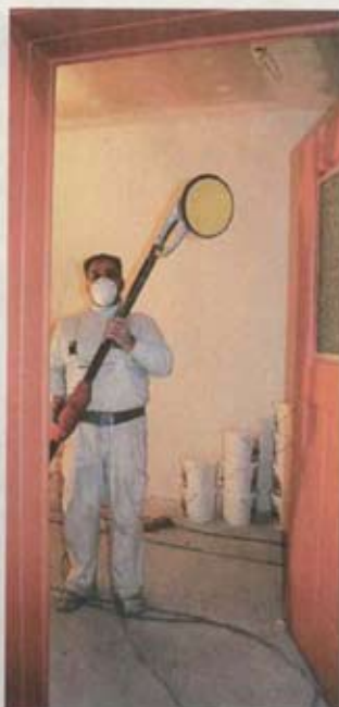
Michael Hartmann gibt den Wänden im Advita-Bereich mit dieser Feinschleifmaschine eine absolut ebene Oberfläche.
