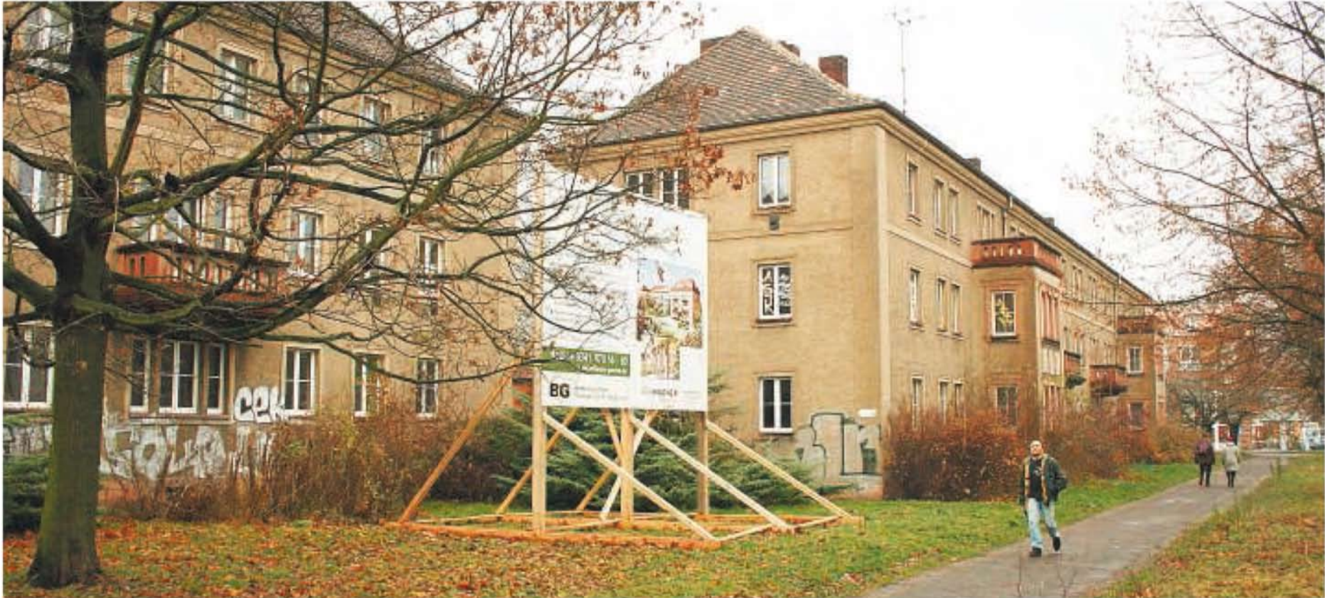
Zuerst werden diese Häuser in der Essener Straße 105 bis 113 denkmalgerecht saniert. Die 113 liegt gleich neben dem Einkaufszentrum an der Mockauer Post. Fotos: Jens Rometsch
