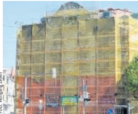
Hinter dem Baugerüst am Ostplatz 2 laufen die Arbeiten jetzt auf Hochtouren.
