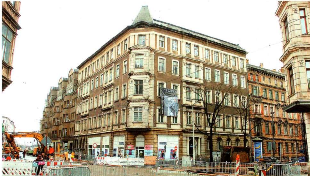
Die aktuellen Verkehrsbauarbeiten in der Jahnallee werden bald durch die Sanierung dieses Häuserensembles mit 150 Wohnungen fortgesetzt. Dabei handelt es sich um das Gelände von Zschaus Garage, einer früheren Autowerkstatt, zu der auch sechs Gründerzeithäuser an der Jahnallee und in der Tschakowskistraße gehören. Foto: Wolfgang Zeyen
